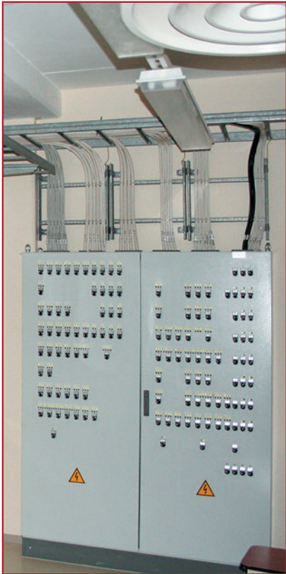
Рис. 3. Шкафы контроля и управления притиводымной защитой
