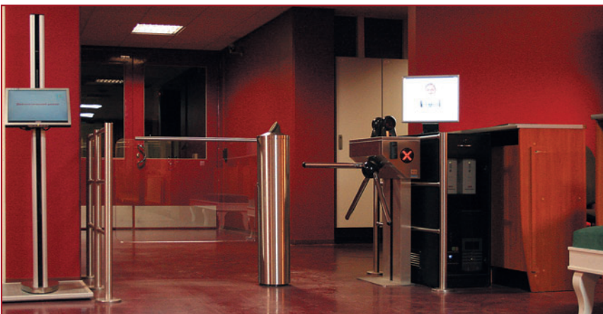
Рис. 5. Один из входов в фондохранилище с системой биометрического доступа
