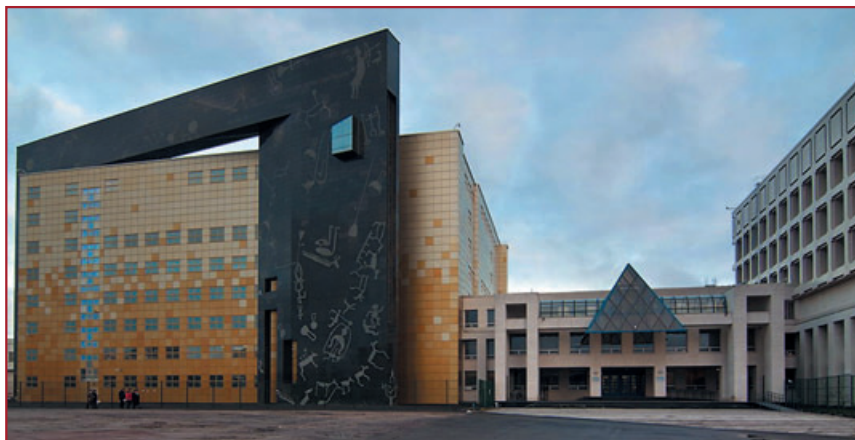
Рис. 1. Новый корпус фондохранилища
