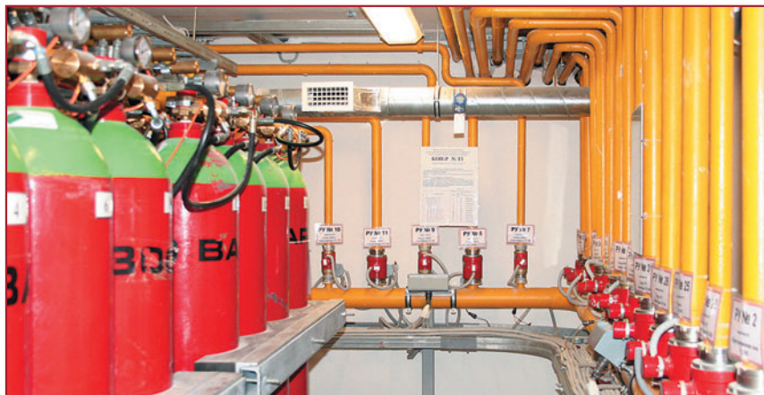
Рис. 2. Станция газового пожаротушения
